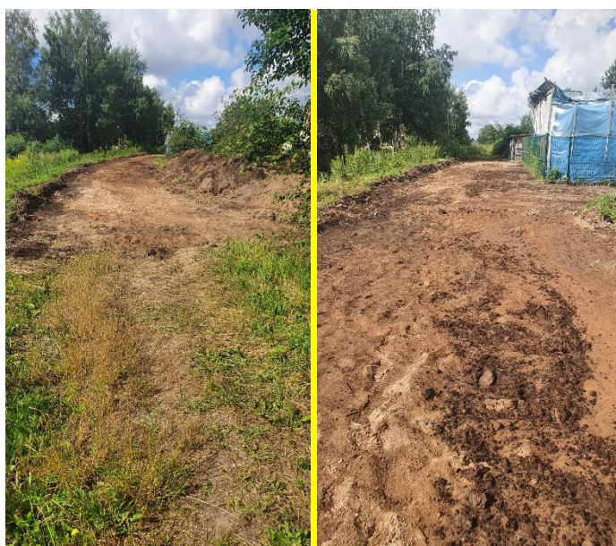
4.līnijas auglīgās augsnes virskārtas noņemšana pirms ceļa slāņu izbūves.
