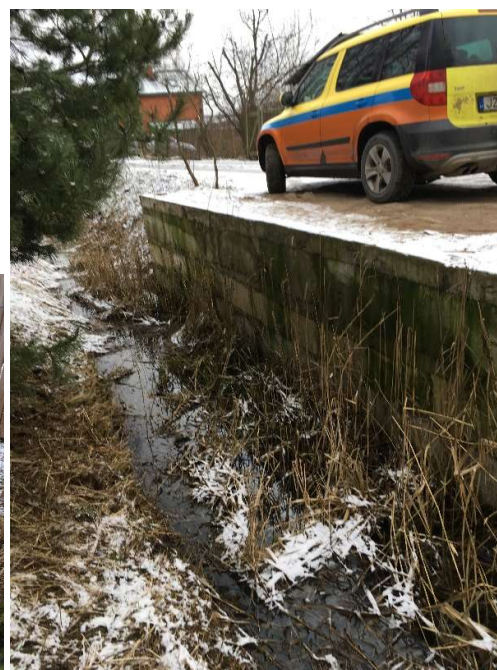
Komunikācijas metāla aizsargcaurulēs S-10 grāvis. Mūra atbalstsiena un ceļa paplašinājums S-12 LK
