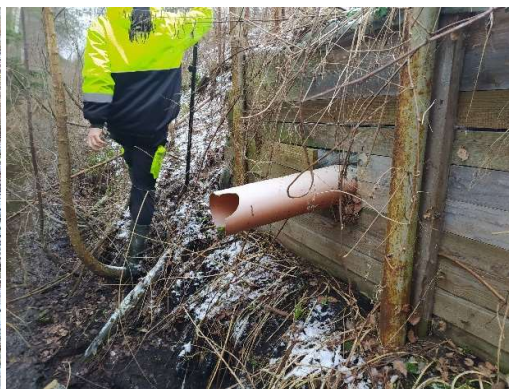
N-1. lietusūd. kanaliz. izteka un koka atbalstsiena
